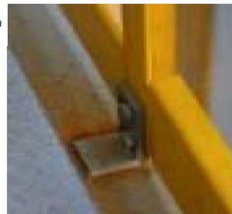
Figura 32 — squadretta saldata di vincolo per connessione del parapetto di dubbia validità
