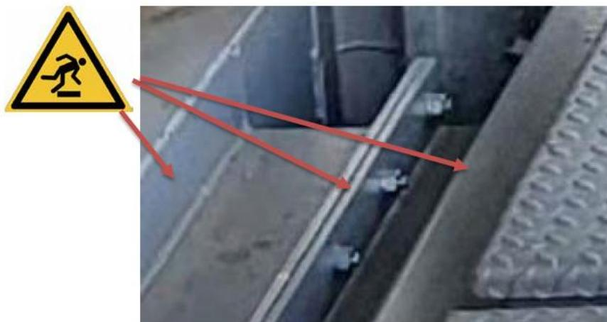
Figura 25 — pericolo di inciampo dovuto alla rimozione di elementi di chiusura su una piattaforma installata su un insieme
